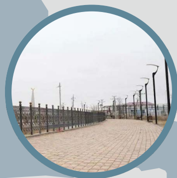
Берегоукрепительные работы в реке Курсай, г. Кульсары, Жылыойский район
